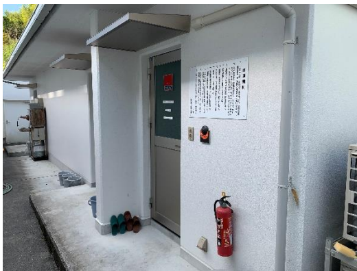
写真 3 工室外観 (手前:南、奥:北) (調査時)
