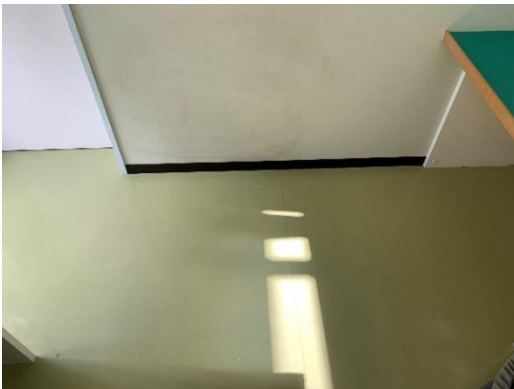
写真 16 床面の状態 (調査時)
