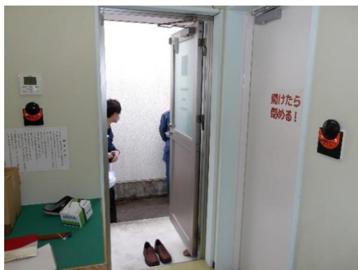
写真 20 出入口 (西) と扉 (壁) (調査時)
